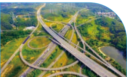
廣州北二環高速公路
